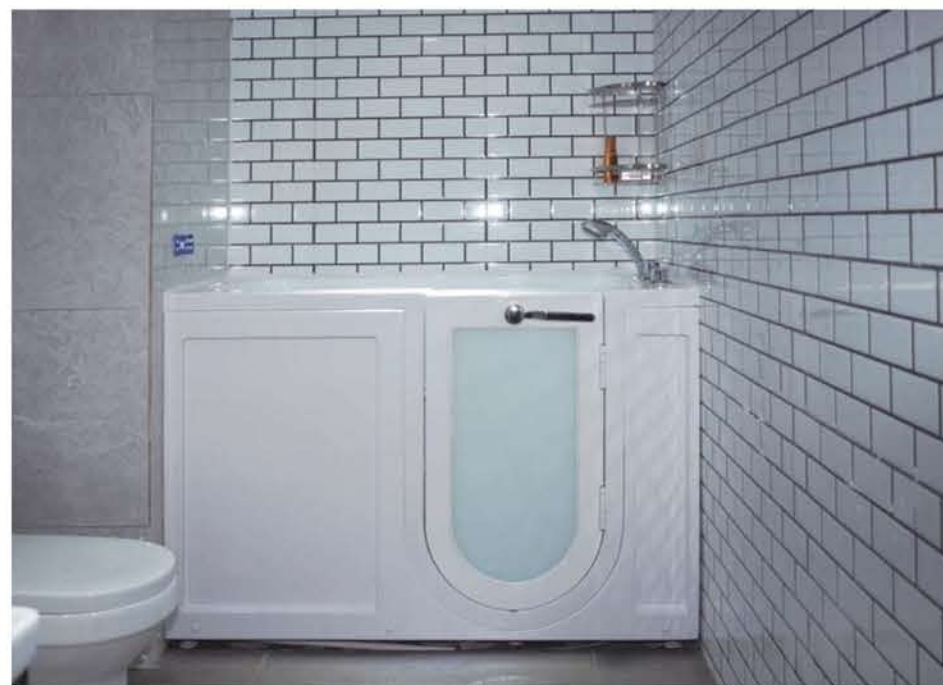
■ 大于 4m 2 卫生间安装开门缸案例
